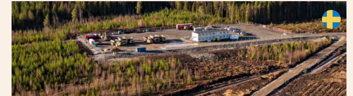
Stegran vety- ja terästehtaan pohja- ja maanrakennustyöt
